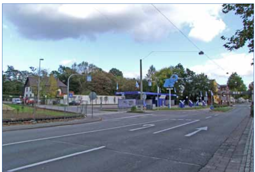
Unzureichend ausgestaltete Eingangssituation von Altenkessel aus kommend, Quelle: Kernplan
