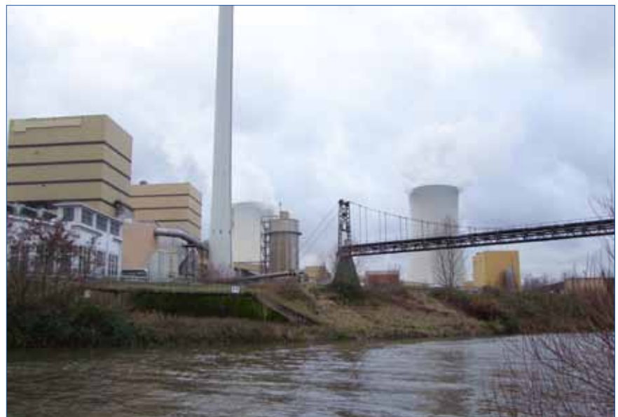
Blick auf das Kohlekraftwerk Fenne vom Saarufer Luisenthals, Quelle: Kernplan
