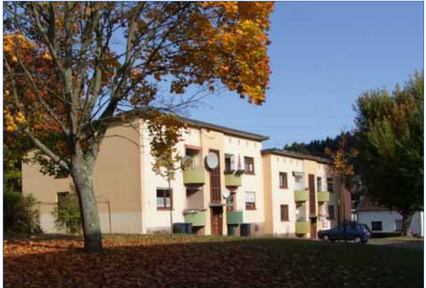
Die Bergarbeitersiedlung an der Altenkesslerstraße stammt aus den 50er Jahren und ist noch im Eigentum der StWB, Quelle: Kernplan
