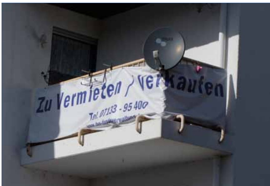
Die Bereitschaft Luisenthal zu verlassen ist groß - damit ist auch die Gefahr weiterer Leerstände präsent. Quelle: Kernplan
