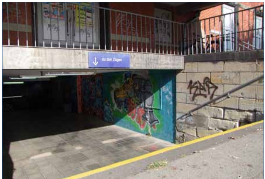
Die Unterführung des "Geisterbahnhofs" ist nicht barrierefrei, Quelle: Kernplan
