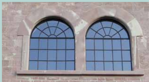
denkmalgerecht sanierte Fassade; Grube Reden; Quelle: Kernplan
