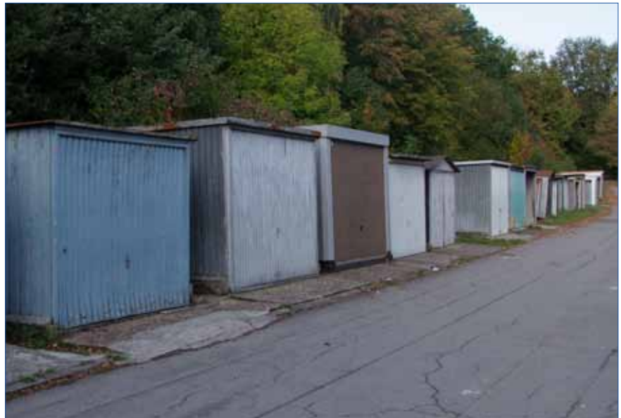
Wellblechgaragen, wie hier in der Altenkessler Straße, prägen das Stadtbild negativ, Quelle: Kernplan
