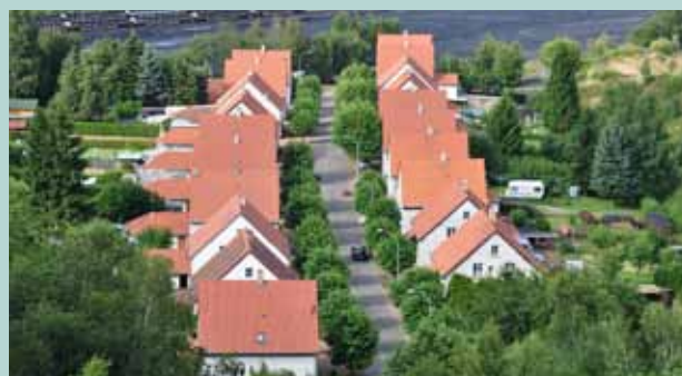
einheitliche Bau- und Grüngestaltung; Madenfelder Hof, Landsweiler-Reden; Quelle: Kernplan
